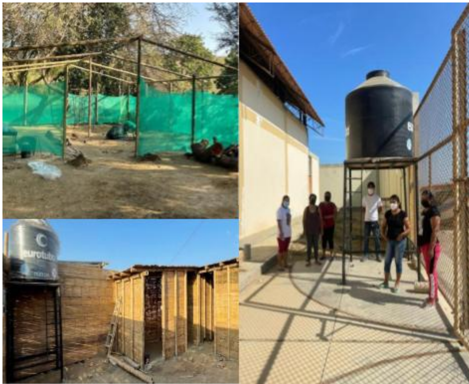
Construcción en zona piloto Máncora
